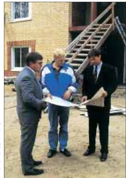
Talousjohtaja (vas.) ja toimitusjohtaja (oik.) osallistuvat suunnitelmien tarkentamiseen vielä rakennuskohteessakin.
